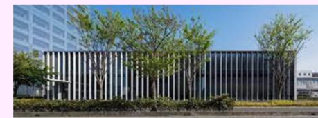
東関東支店ZEB改修（2015）
